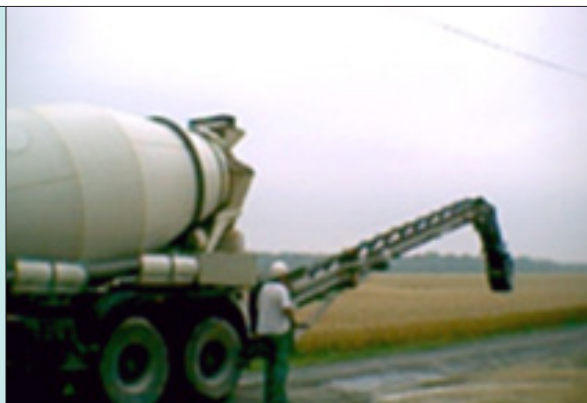
Foto 1: Auto betoneira equipada de um tapete que o operador encolhe
